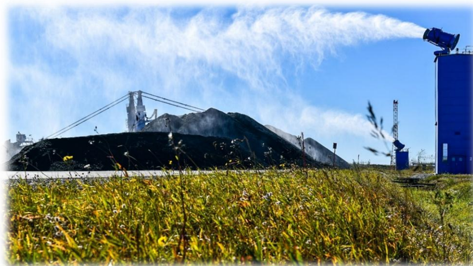
Рис. 2.6. Стационарная система пылеподавления штабелей угля
